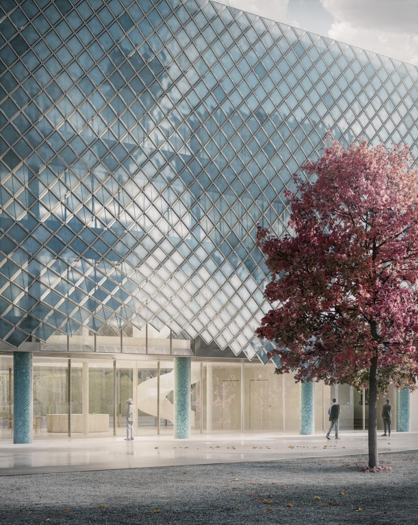
Etude de cas 1 : Maison de la santé, Bienne I :mlzd Architectes Façade double peau solaire
